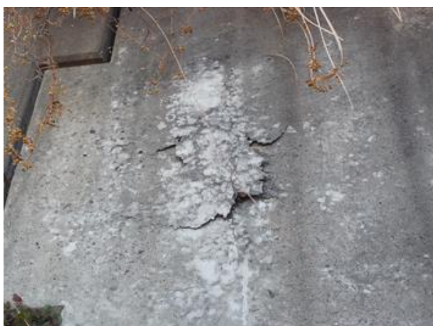
写真-1 コンクリートの剥離・うき
