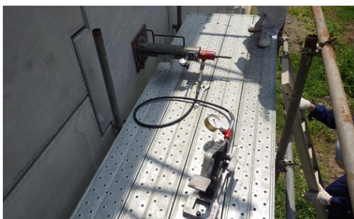
図-8 補強材の引抜き試験
