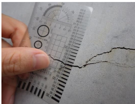
図-7 ひび割れの計測（クラックスケール）
