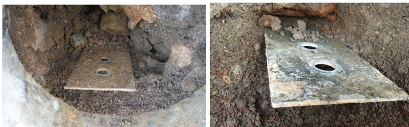
図-9 壁面削孔による補強材の外観観測
