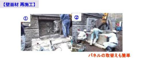
具体的な補修、補強方法については、「補強土（テールアルメ）壁工法設計・施工マニュアル（第4回改訂版）平成26年8月」の『7.5 補修及び補強対策』（P.263～）に詳細が記載されているが、補強材の健全性及び補強効果が確認された場合は、壁面のみの交換で補修は可能となる。
