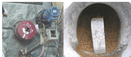
写真-1, 2 壁面材の削孔
