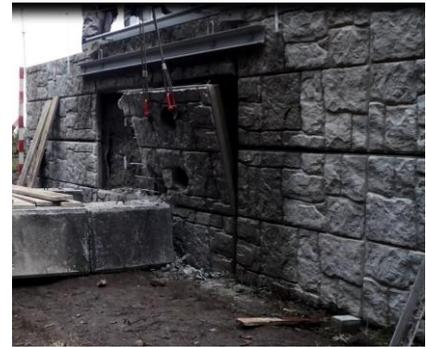
写真-3 壁面の取り外し状況
