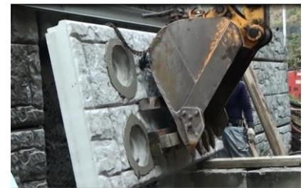
写真-5 壁面材設置状況
