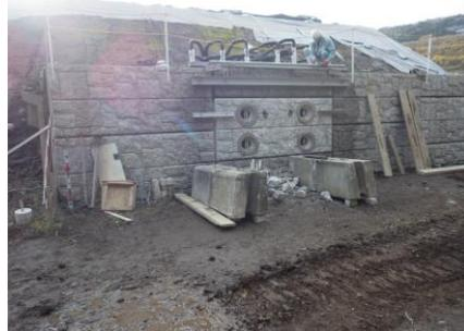
写真-6 結合治具設置後
