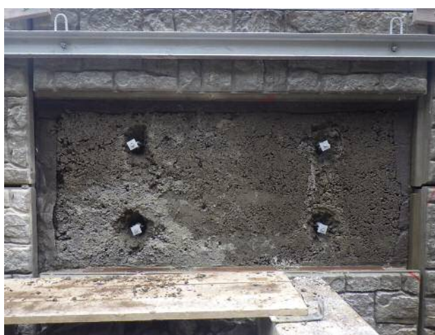
図5 壁面材撤去後の状況
