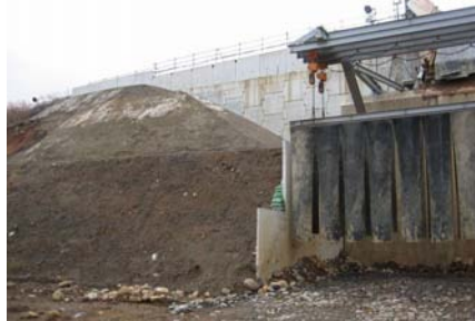
写真-2 災害復旧(左側押え盛土)
