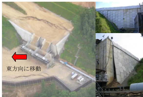
写真-1 被災状況
