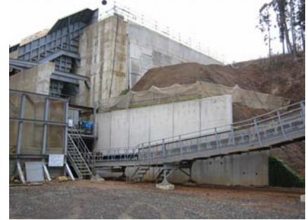
写真-3 災害復旧(右側押え盛土)
