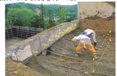
写真-1 盛土の掘削状況 (GL-0.375m)
