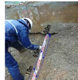
写真-2 引込み沈下量の測定
