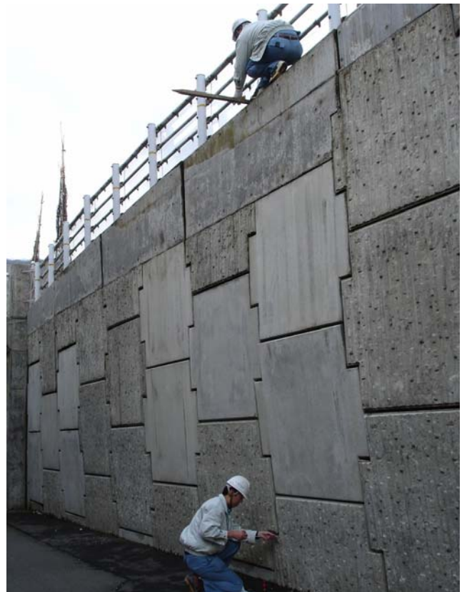
写真-1 テールアルメの変状調査の状況
