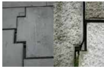
写真-1 壁面材目違いおよび損傷
