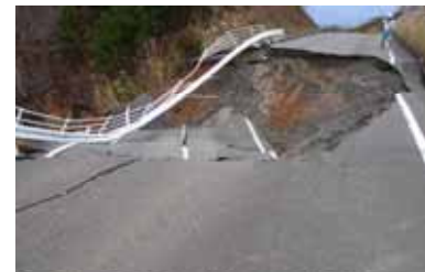
写真-4 一般盛土部の崩壊
