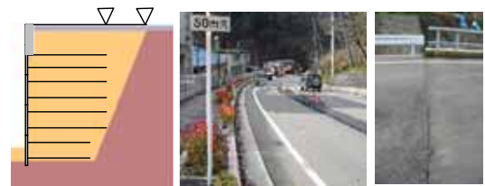
図-3, 写真-3 道路部の舗装面の損傷
