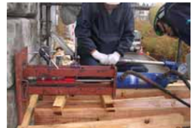
写真-5 引抜き試験状況
