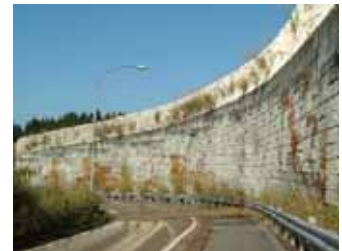
写真-2 全景（終点部より）
