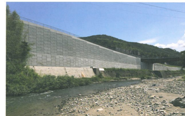
地区名/和歌山県（海草振興局） 工事名/国道370号道路改良工事 施工時期/2014.10
