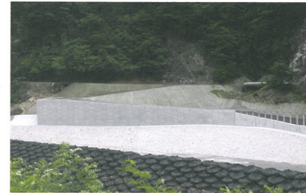
地区名/長野県（国交省中部地整天竜川ダム統合管理事務所） 工事名/小渋ダム土砂バイパス呑口工事 施工時期/2015.01
