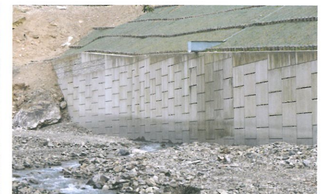
地区名/三重県（松阪農林事務所） 工事名/災害復旧事業（東又谷） 施工時期/2013.08
