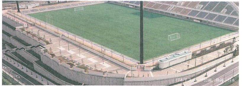
より高く、自由に伸びやかな線形が、大規模施設に特徴的な表情を与える
