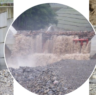
2015年7月17日 台風接近時、現場の状況
