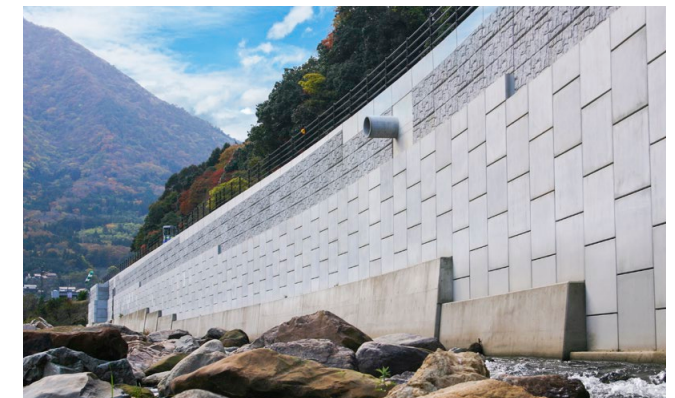
島根県 国道9号津和野川
