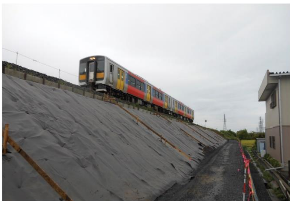
施主：東日本旅客鉄道株式会社 工事名：JR水郡線法面復旧工事 ■ のり面勾配：1 : 1.5 ■ 型式：T-200LP ■ のり面積：1,130㎡
