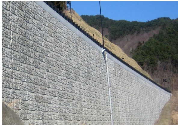
テールアルメ工法
