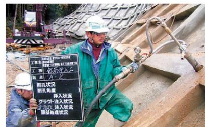
2方向加圧注入の実施
